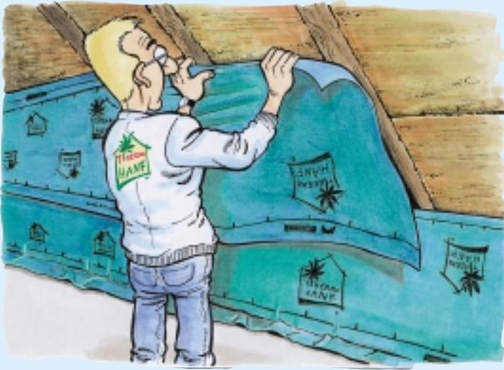
Maintenant, on doit poser le film pare-vent. Theo a reçu le pare-vent en papier ouvert à la diffusion avec sa livraison de Thermo-Chanvre®.
