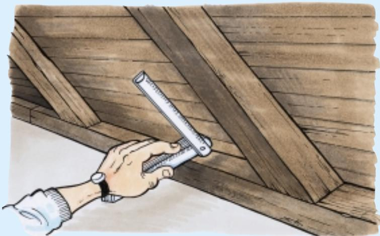
Pour une bonne efficacité, Theo met du Thermo-Chanvre® partout dans la maison, même dans les coins. Il mesure l'angle entre le sol et le rampant...
