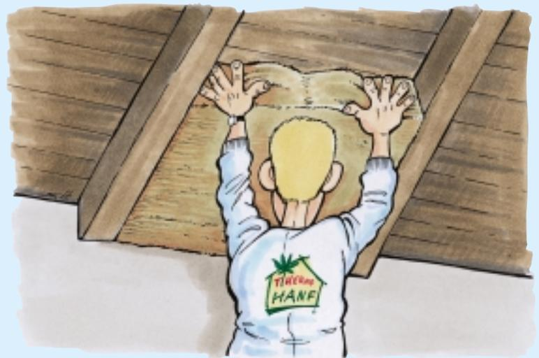
... et presser légèrement afin d'éviter les ponts thermiques. Ça fonctionne parfaitement.
