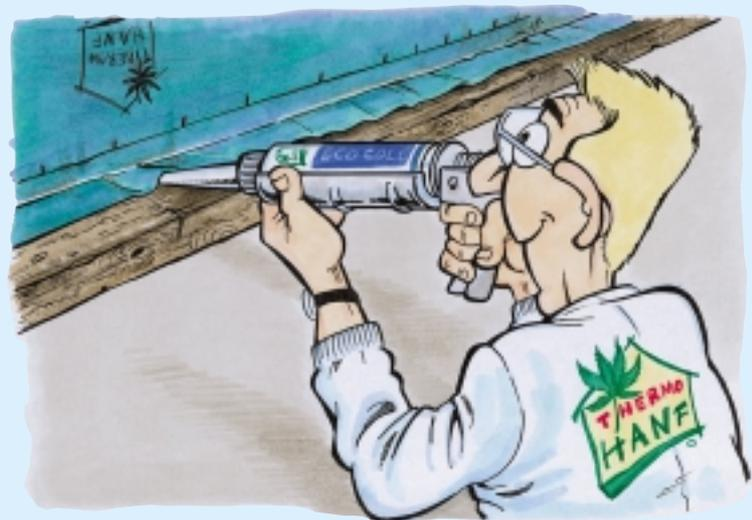
... et Theo colle les raccords entre le pare-vent, les murs, le sol ainsi que les raccords avec les fenêtres de toit avec EcoColl – ça colle super.
